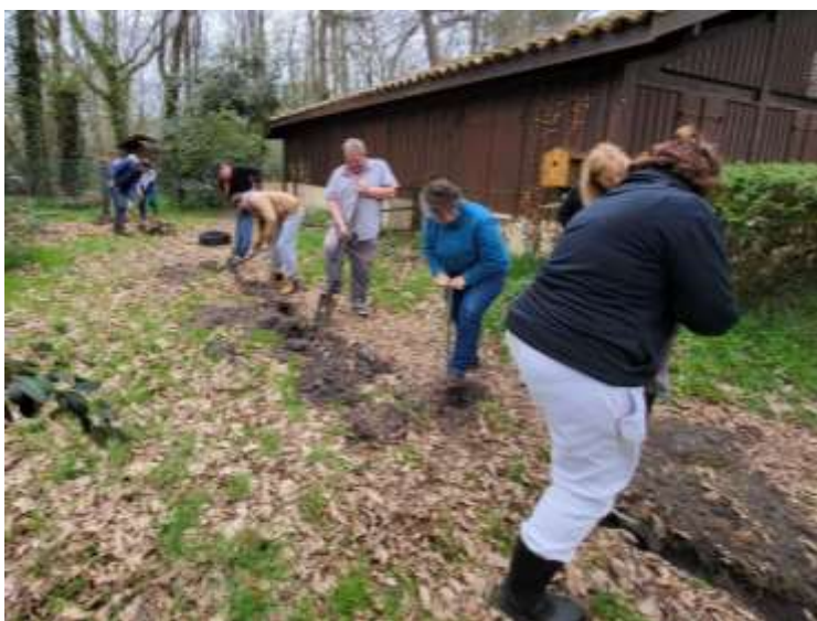
Les bénévoles creusent le système d'irrigation
